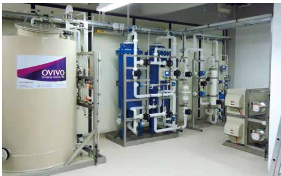
Ovivo richt zich bij de nieuwe installatie in de eerste plaats op het hergebruik van afvalwater.
